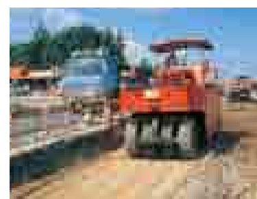
改良手順5 (転圧)
