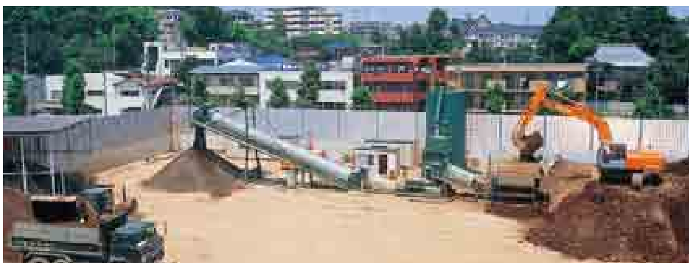
建設発生土改良プラント
